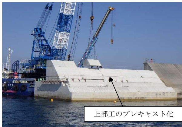
プレキャスト部材導入の一例（志布志港防波堤）
