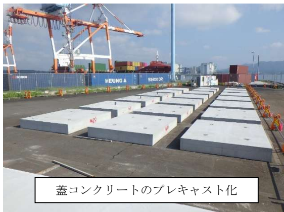
プレキャスト部材導入の一例（志布志港防波堤）
